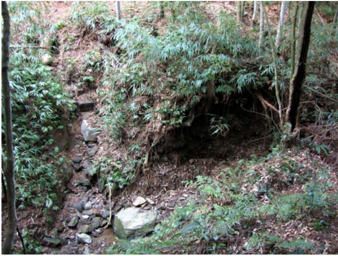
図 11 南岸斜面側からみた南谷水門
