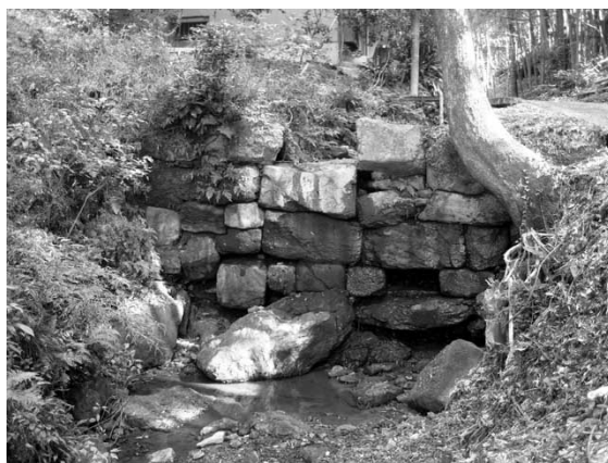
女山神籠石の粥餅谷水門（瀬高町大字大草） 片岩系の石と列石と同じ水成岩の切石を基盤岩上に 4 段に重ねて構築する。下部には谷の水を逃がす水口を設ける。
